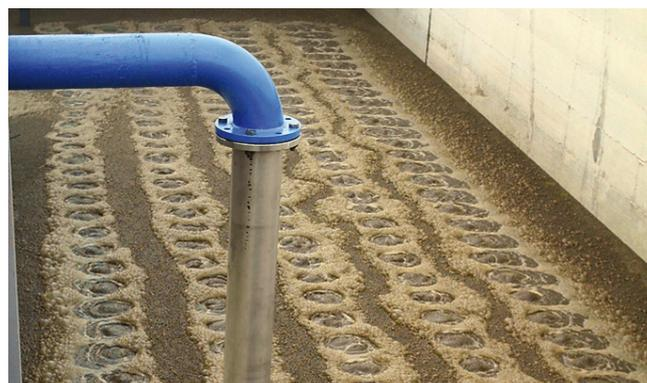
Zenit dispone di diffusori d'aria a membrana a disco e tubolari. Entrambi i modelli sono caratterizzati da membrana di alta qualità con foratura per una aerazione ad elevato trasferimento di ossigeno con perdite di carico contenute, limitando al massimo i consumi energetici necessari. I diffusori a disco possono essere dotati di valvola di ritegno a sfera integrata.
