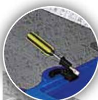
Il passaggio dei cavi elettrici avviene attraverso speciali pressacavi brevettati che consentono una perfetta tenuta. Prima di inserire il cavo, forare i pressacavi necessari con un utensile appuntito e lasciare inalterati gli altri per evitare fuoriuscite di liquido o di odori. Se la pompa è dotata di spina, praticare nel pressacavo un taglio longitudinale su un lato per consentire il passaggio del cavo senza compromettere la tenuta.
