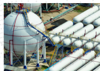
DEPOSITI GAS E IDROCARBURI
