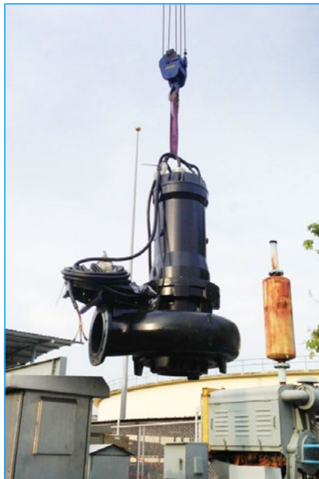
Fasi di installazione
