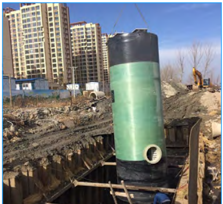
L'installazione del Box GRP
