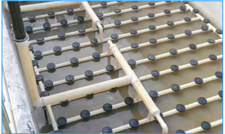
Gli Oxyplate installati
