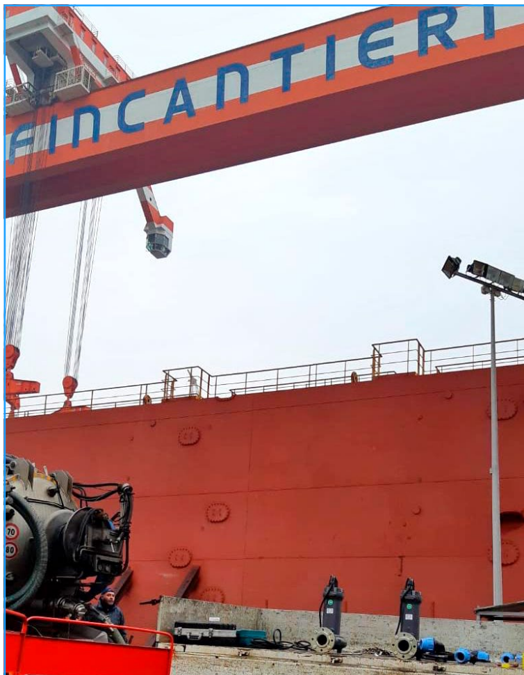
Fasi di installazione
