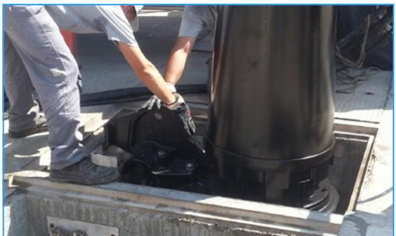
Dettaglio del DAC [dispositivo di accoppiamento]
