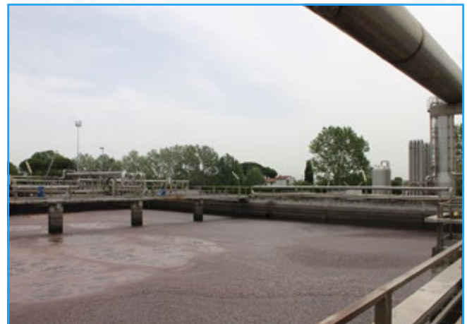
Deux des cuves de l'installation de traitement où sont installées les machines Zenit
