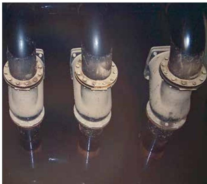
Les vannes à guillotine, avec commande par volant, sont en mesure d'exécuter plusieurs fonctions et sont utilisées comme des organes de retenue pour régler le débit d'un tuyau ou pour isoler temporairement un secteur de l'installation.
