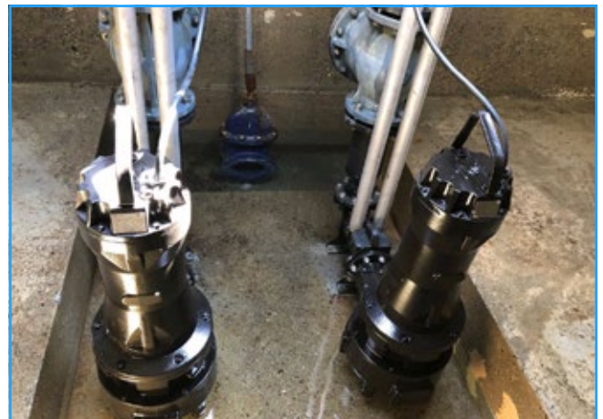
La instalación de Zenit UNIQA en el sumidero.
