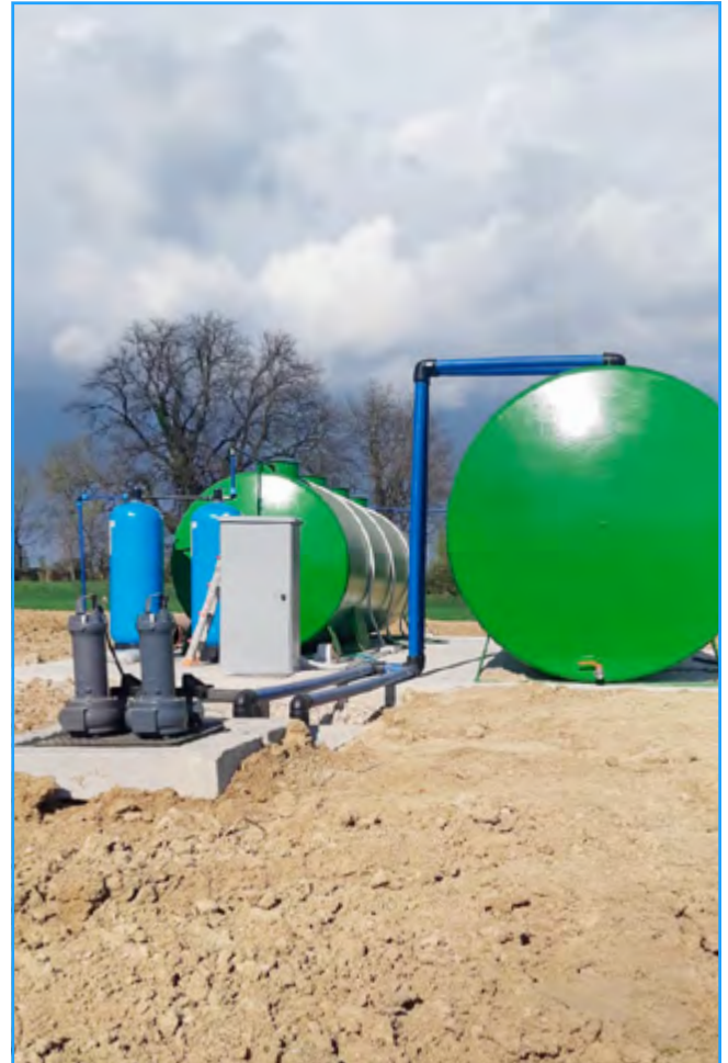
Fases de instalación
