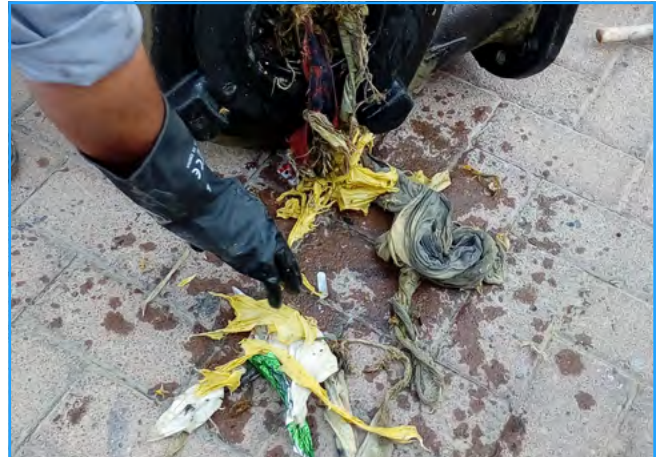
La bomba reemplazada con problemas de obstrucción.
