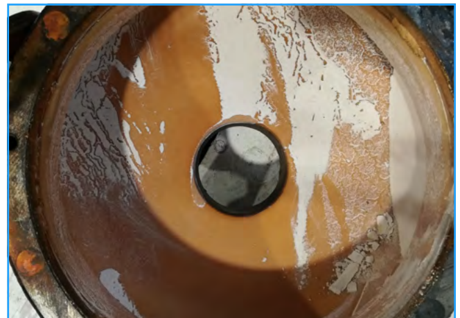
El revestimiento del sistema hidráulico de Uniqa en vulkollan
