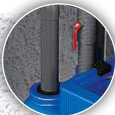
Acoplar en el **blueBOX** los tubos de entrada de aguas residuales y el conducto de desahogo, si está presente.
