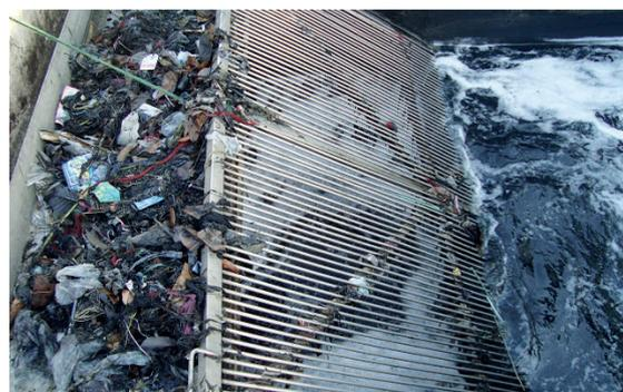
污水中通常存在着不同杂质，包括纤维状杂物，塑料甚至金属类固体颗粒。常规的切割泵过流能力弱，流量小，因此无法适用。更重要的是，采用通过限制流量的方式意味着需要消耗很长时间才能排空坑中的污水。
