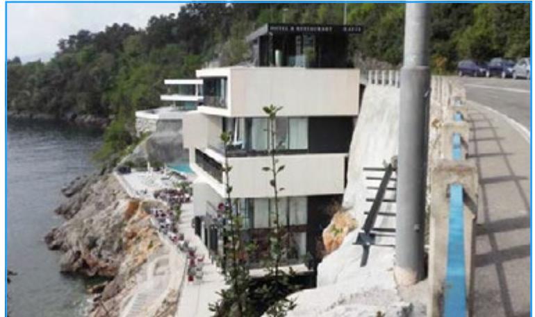
Navis Hotel, ingresso dalla strada
