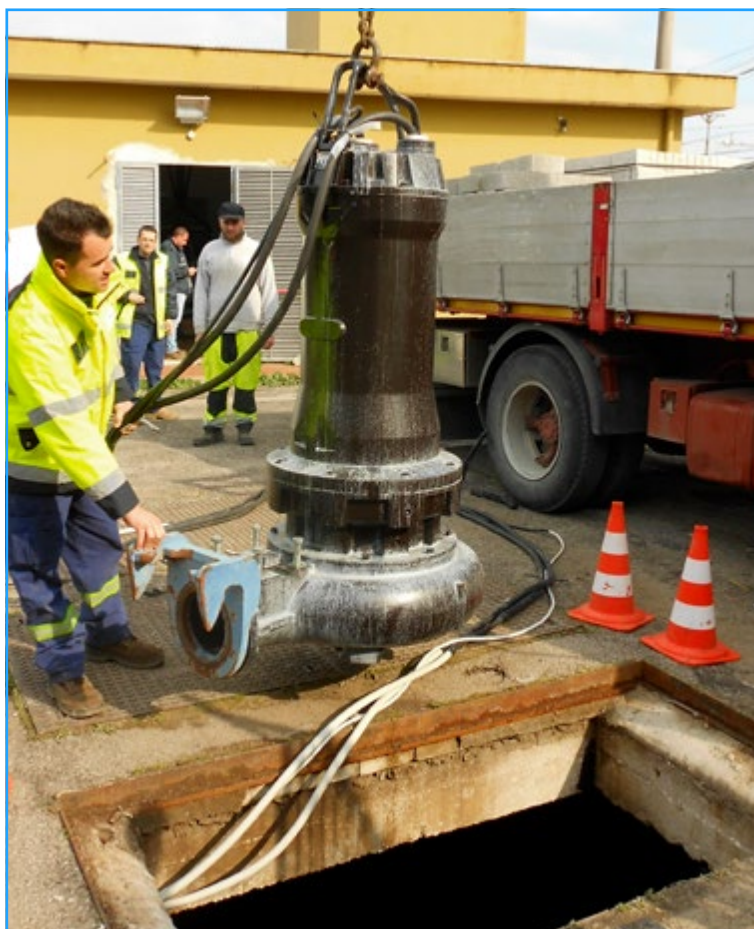
L'installazione della Zenit UNIQA ZUG OC 200C 75/6 AW
