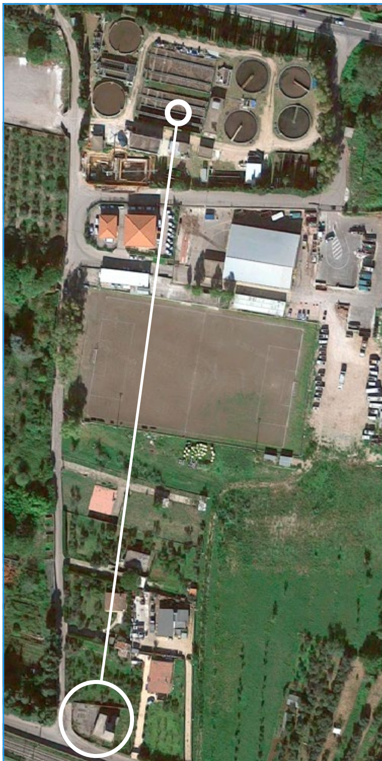
La stazione di rilancio ed il depuratore
