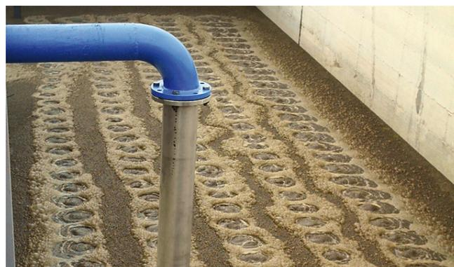
Zenit propose plusieurs diffuseurs d'air à membrane : disques et tubulaires. Les deux modèles comportent une membrane perforée de très grande qualité pour une aération avec transfert élevé d'oxygène et limitation des pertes de charge, réduisant ainsi au minimum la consommation d'énergie. Les disques diffuseurs d'air peuvent intégrer un clapet anti-retour à bille.
