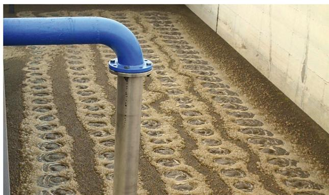
Zenit dispone de difusores de aire con membrana de disco y tubulares. Ambos modelos llevan una membrana de alta calidad perforada para ofrecer una aireación con elevada transferencia de oxígeno pero limitando las pérdidas de carga y reduciendo al máximo el consumo de energía necesario. Los difusores de disco se pueden equipar con una válvula de retención de bola integrada.
